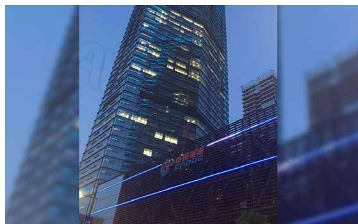
深圳中国海油大厦 智能会商系统
