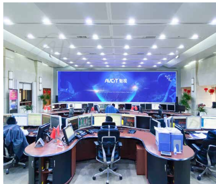
南网广西电网 电力调度控制中心
