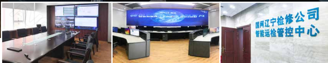
国网辽宁检修公司 智能运检管控中心
