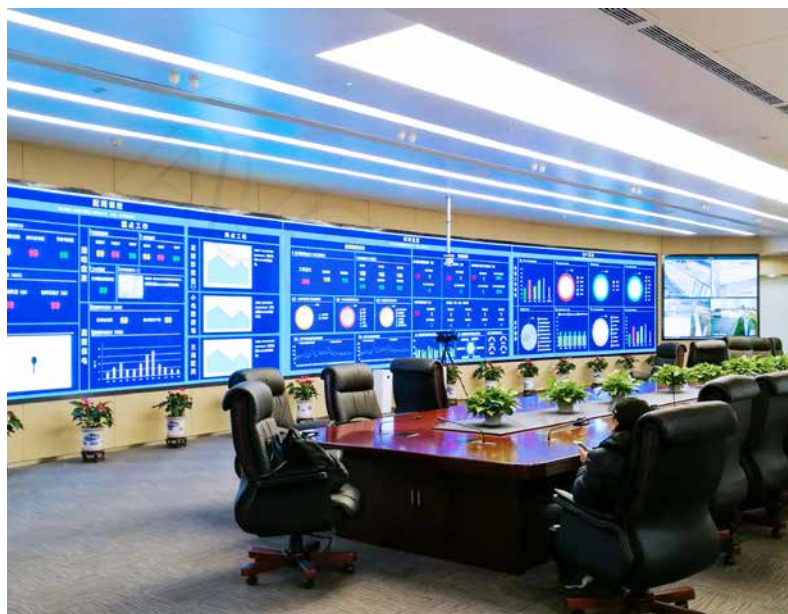
国网苏州供电公司 供电服务指挥、应急指挥、生产管控“三合一”中心
